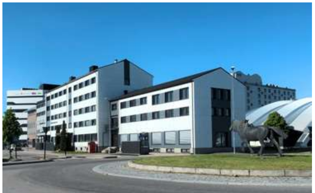
Landbruksbygget har i 2018 fått en oppgradering av fasaden.
