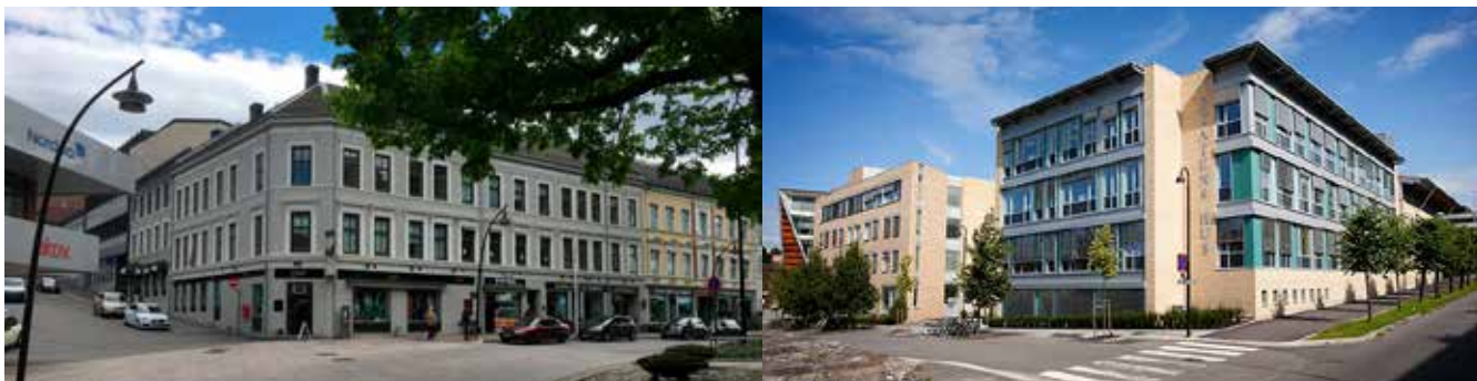
Strandgata 55 og Statens Hus i Hamar.
