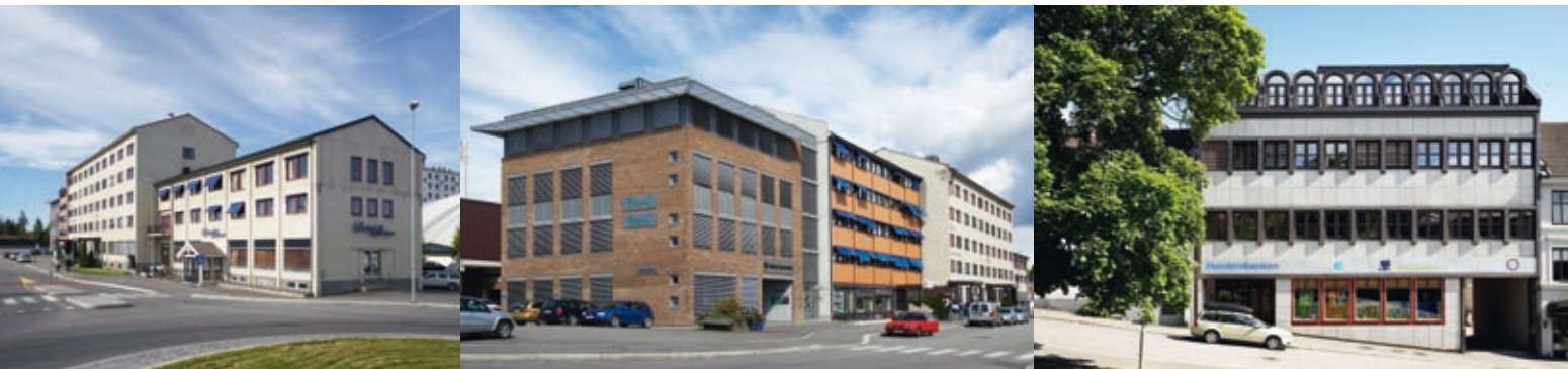
Vangsveien 121 og Seminargt 1, begge i Hamar.
